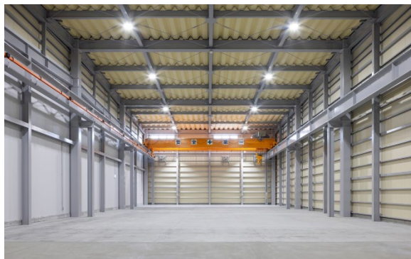
クレーン倉庫
